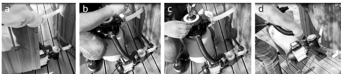
Obr. 17. Demontáž pískové filtrace.
