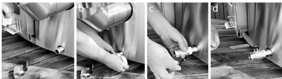
Obr. 11. Montáž vypouštěcího ventilu.
