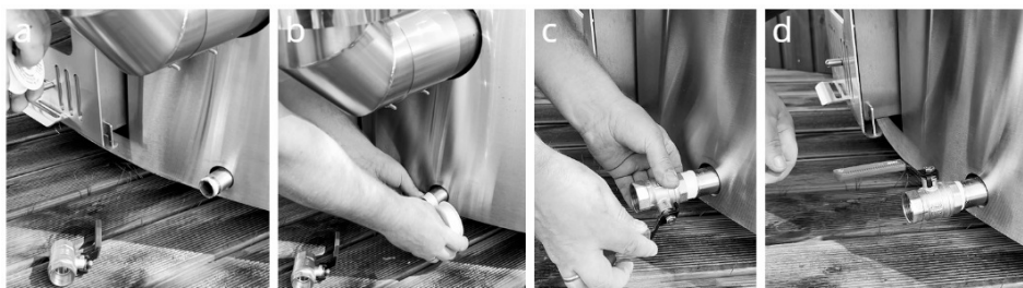
Obr. 11. Montáž vypúšťacieho ventilu.
