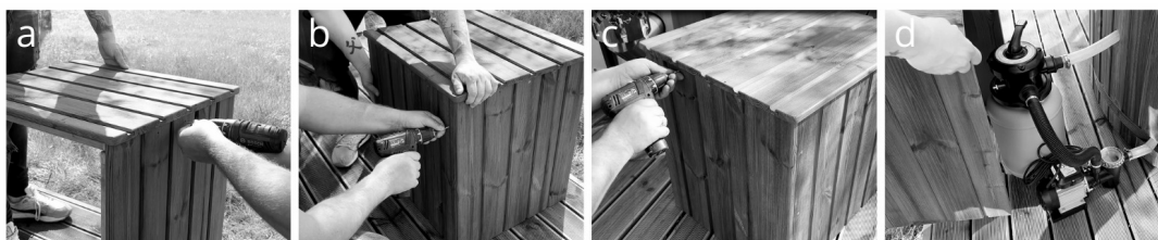
Obr. 13. Montáž dreveného krytu pieskovej filtrácie.
