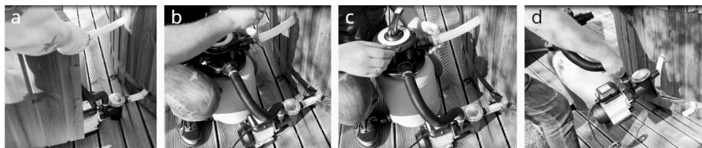
Obr. 17 Demontáž pískové filtrace
