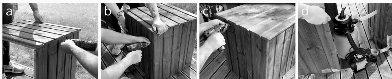
Obr. 13 Montáž dřevěného krytu pro systém pískové filtrace
